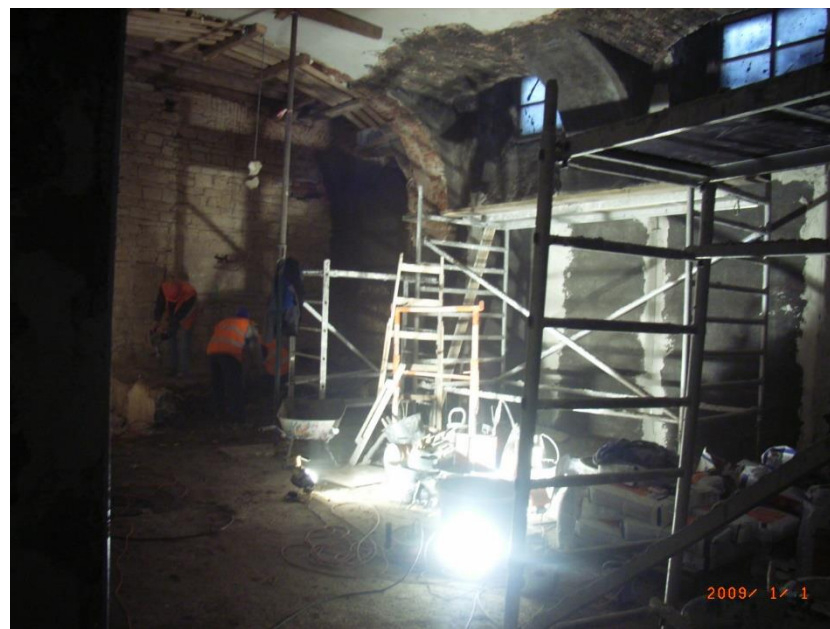
Rekonstrukce prostor přilehlých k depozitáři. Zdroj: dokumentace ÚVI
